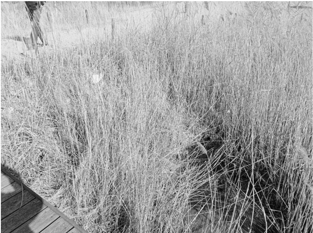
2. Ubezpieczenie z narzutu kamiennego i porost trzciny brzegu kąpieliska w rejonie pomostu pływającego
